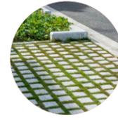
① Pavimento infiltrante en estacionamientos
